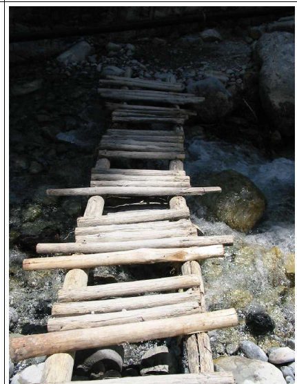
Griechische Brückenbaukunst, mal ganz ohne Beton.
